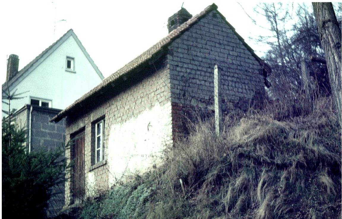
Das ehemalige Backhaus im „Rotenberg“ um 1967 auf dem Grundstück von Wolfgang Retzler, Mittelbollenbacherstrasse 71.
