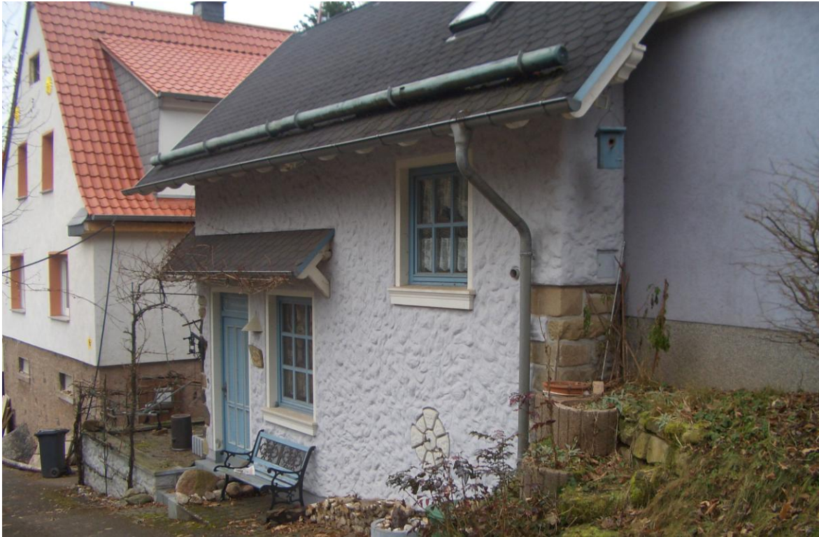
Das umgebaute Backhaus Kreßtel und links das renovierte Haus Lang im Jahre 2008.
