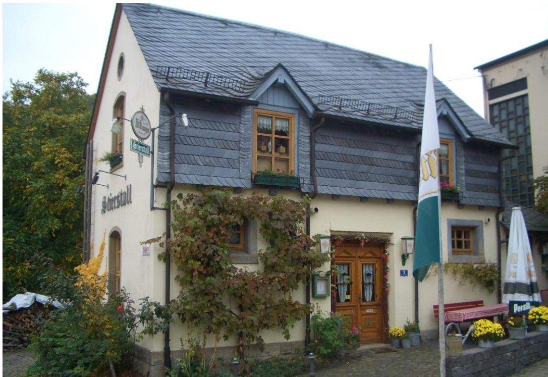
Der Stierstall, zur Gaststätte umgebaut, im Oktober 2008
