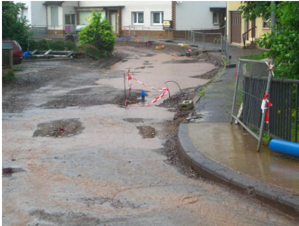
Während der Bauarbeiten in der Mittelbollenbacherstrasse im Mai 2009, führte ein Wolkenbruch zu Hochwasser, das sowohl die Strasse als auch den Kanal- und Wasserleitungsgraben überflutete.
