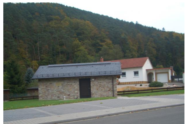
Die neue Druckminderanlage zur Regulierung des Versorgungsdruckes in Mittelbollenbach an der Steingartenstraße Oktober 2010.
