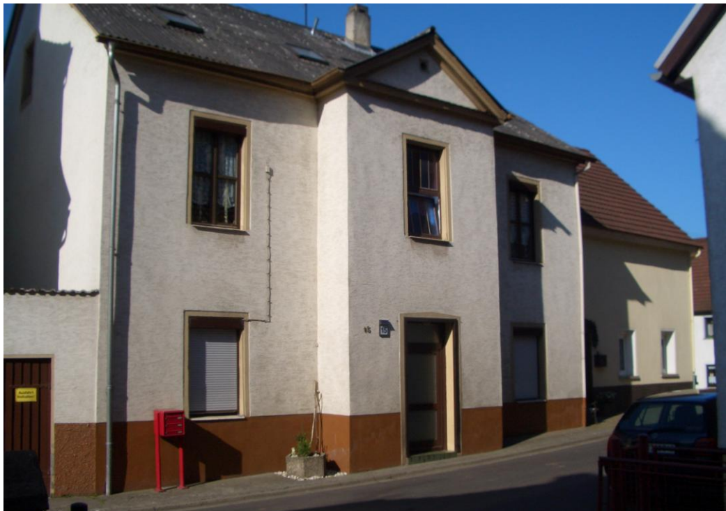
Ehemaliges katholisches Schulhaus von 1846.
