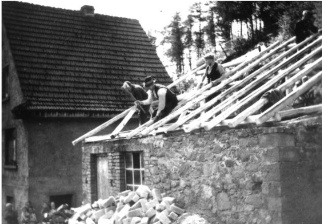
Der Backhausbau in Kreßtel 1933
