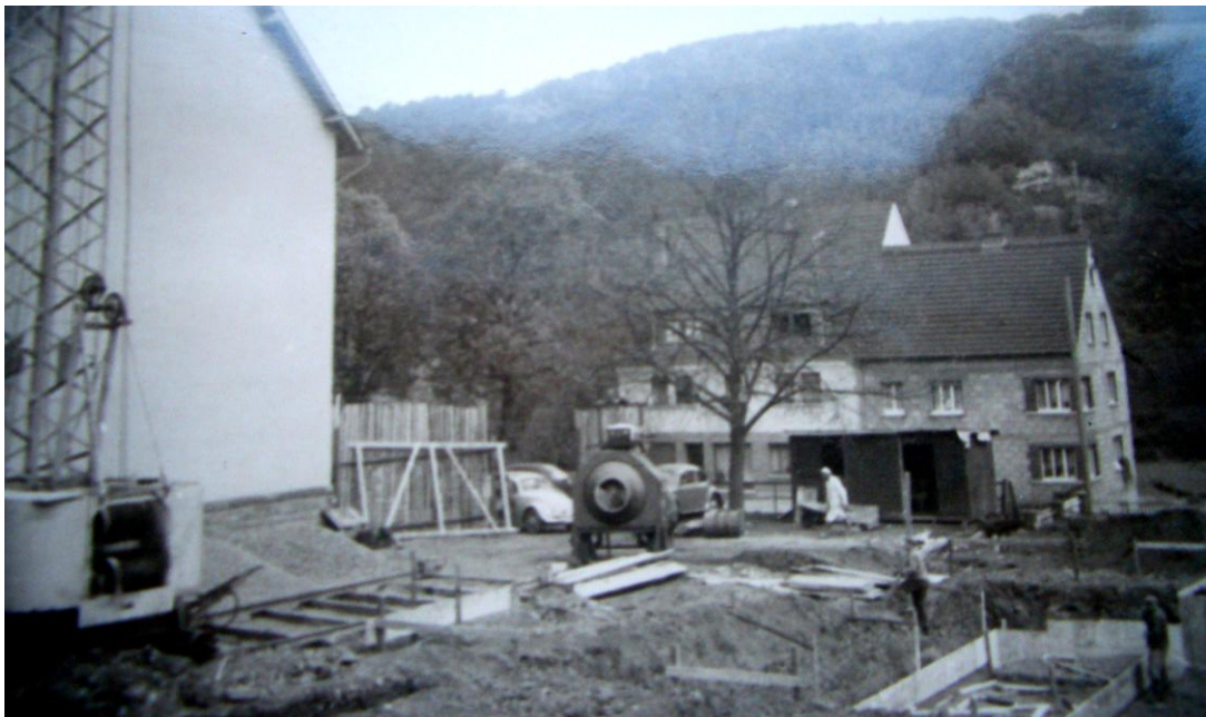
Baustelle der Schulhauserweiterung 1962
