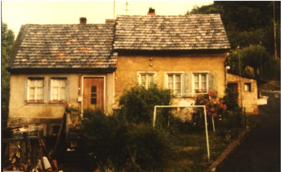
Die Häuser Karl Kurz und Gerald Wahl in der Steingartenstrasse um 1970. Das Bild wurde von der Brücke über den Bollenbach aus aufgenommen. Beide Häuser wurden 2011 von Elke Muy und Bernd Mildenberger erworben. Das Haus Kurz (links) wurde abgerissen und das Haus rechts umgebaut und renoviert und wird von den Eigentümern bewohnt.
